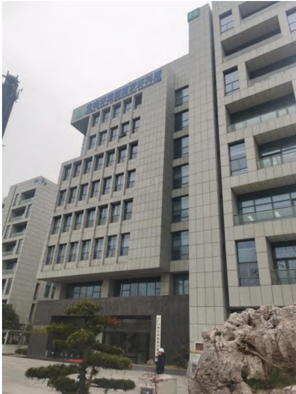
主体大楼外貌
