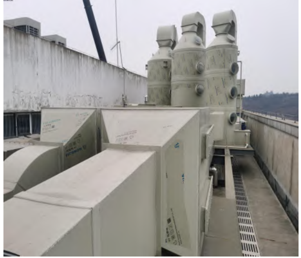
P1 酸性废气 3 套处理设施
