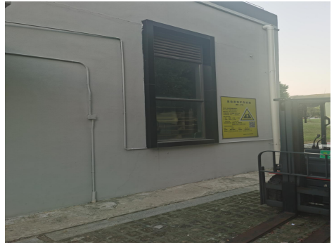
园区危废仓库标牌和视频监控
